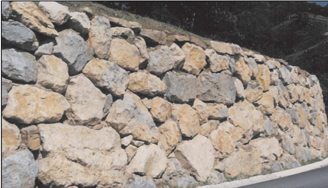
Imagen 19. Muro de escollera. Fuente: Guía para el Proyecto y la Ejecución de muros de escollera en obras de Carreteras del Ministerio de Fomento.
