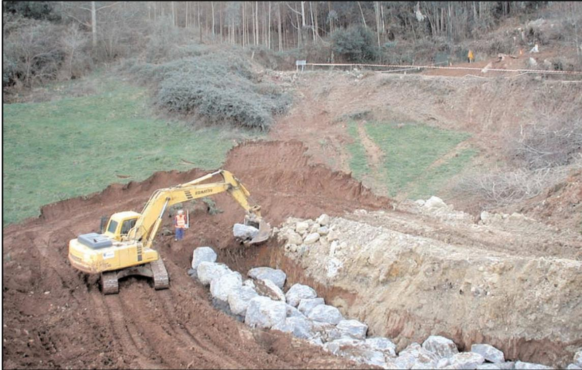
Imagen 37. Colocación de bloques en el cimiento. Fuente: Guía para el Proyecto y la Ejecución de muros de escollera en obras de Carreteras del Ministerio de Fomento.
